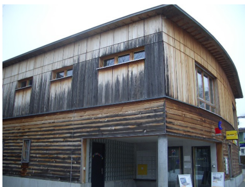
Unbehandelte, ungleichmässig vergraute Holzfassaden
